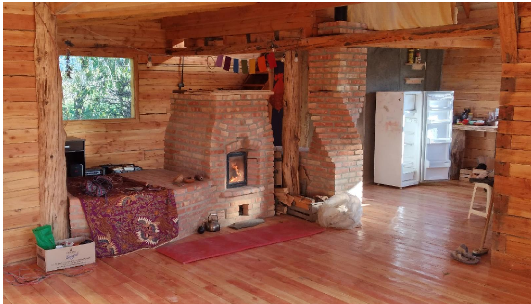
Estufa Gymse Clásica Banco térmico isla tipo campana
