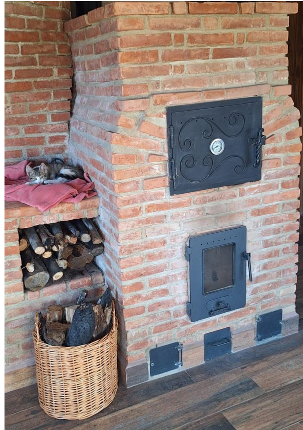
Estufa Gymse combinada + horno blanco + pulmón Banco térmico de campana
