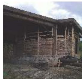
9 TÉCNICA: Quincha húmeda. Técnica elegida por su versatilidad en la materialidad, su fácil ejecución, su bajo costo y su eficiencia térmica. La quincha húmeda tiene una trasmittancia térmica de 2,64 W/2K (Cutiño 2015) en una pared de 10 cm de espesor. La arcilla aplicada en el relleno y en los revoco regula la humedad ambiente. La quincha permite generar grandes vanos para recibir buen asoleamiento, buena ventilación y aprovechar las visuales del sitio. La quincha es una técnica mixta por lo que la estructura portante y sismorresistente se logra con una estructura de madera de rollizos de eucalipto, material que proviene de bosques reforestados, reciclable, bio degradable.
