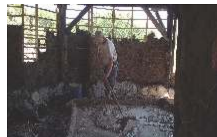
8 MATERIALES arcilla, arena, paja de cortadera reciclada, madera, piedra, tierra negra, cañas son los elementos principales que componen la vivienda.
