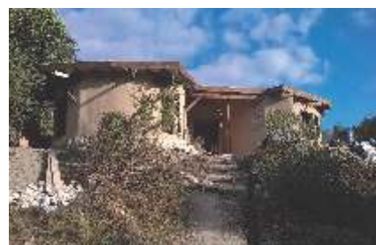
9 TÉCNICA: Quincha húmeda. Técnica elegida por su versatilidad en la materialidad, su fácil ejecución, su bajo costo y su eficiencia térmica. La quincha húmeda tiene una trasmittancia térmica de 2,64 W/2K (Cutiño 2015) en una pared de 10 cm de espesor. La arcilla aplicada en el relleno y en los revoco regula la humedad ambiente. La quincha permite generar grandes vanos para recibir buen asoleamiento, buena ventilación y aprovechar las visuales del sitio. La quincha es una técnica mixta por lo que la estructura portante y sismorresistente se logra con una estructura de madera de rollizos de eucalipto, material que proviene de bosques reforestados, reciclable, bio degradable.
