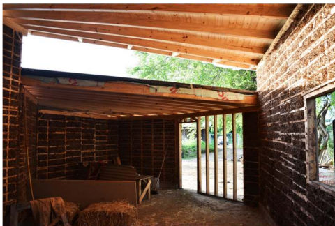
Muro de quincha en proceso
